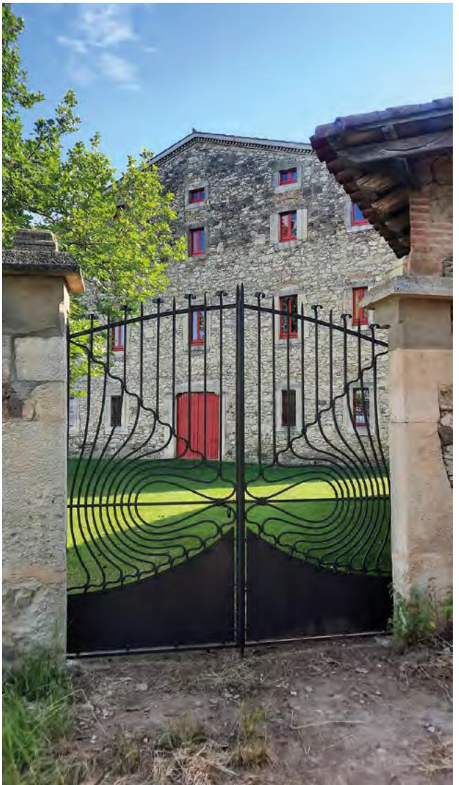
Para Menorca, que es un ambiente salino, tiene que ir todo galvanizado, lacado y no se puede estar soldando encima, va con tornillos, se lleva desmontado y allí tiene que encajar todo a la perfección.
